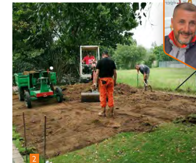
POSE DES MURS, CHARPENTE, COUVERTURE, MENUISERIES ET RÉALISATION DE LA DALLE BÉTON
